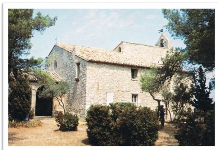
Avant sa restauration
